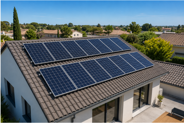
1. Panorámica de la instalación en cubierta
